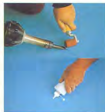
Totale afdichting gegarandeerd door het lassen met warme lucht en afwerking met vloeibare PVC.
